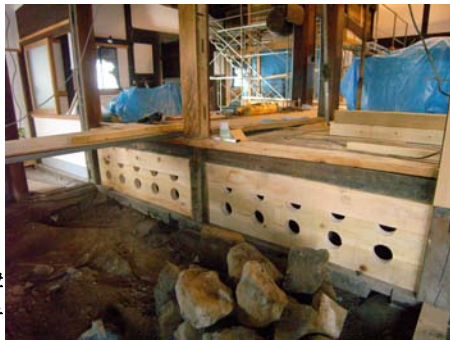
足固め設置床下の様子
